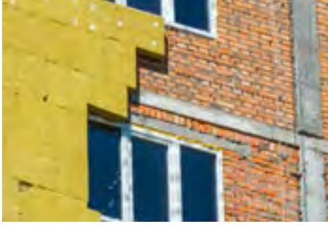
Görsel 4.28. Isı yalıtımı yapılan bina
