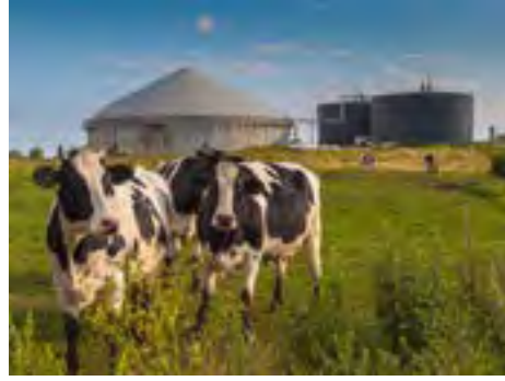
Görsel 4.40. Biyogaz üretim tesisi
